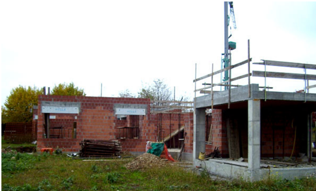
Fagagna: vista del cantiere.
