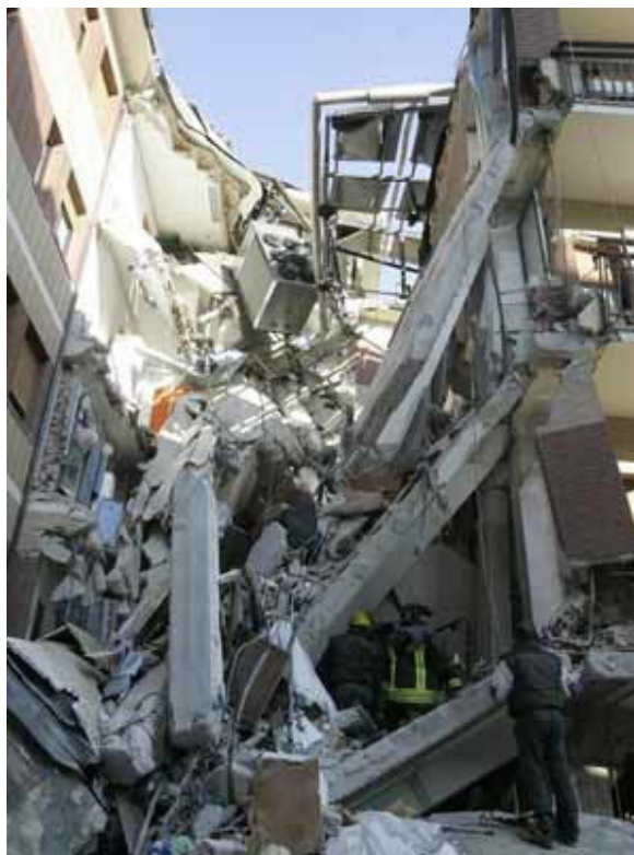
Edificio crollato durante il terremoto del 6 aprile 2009.
