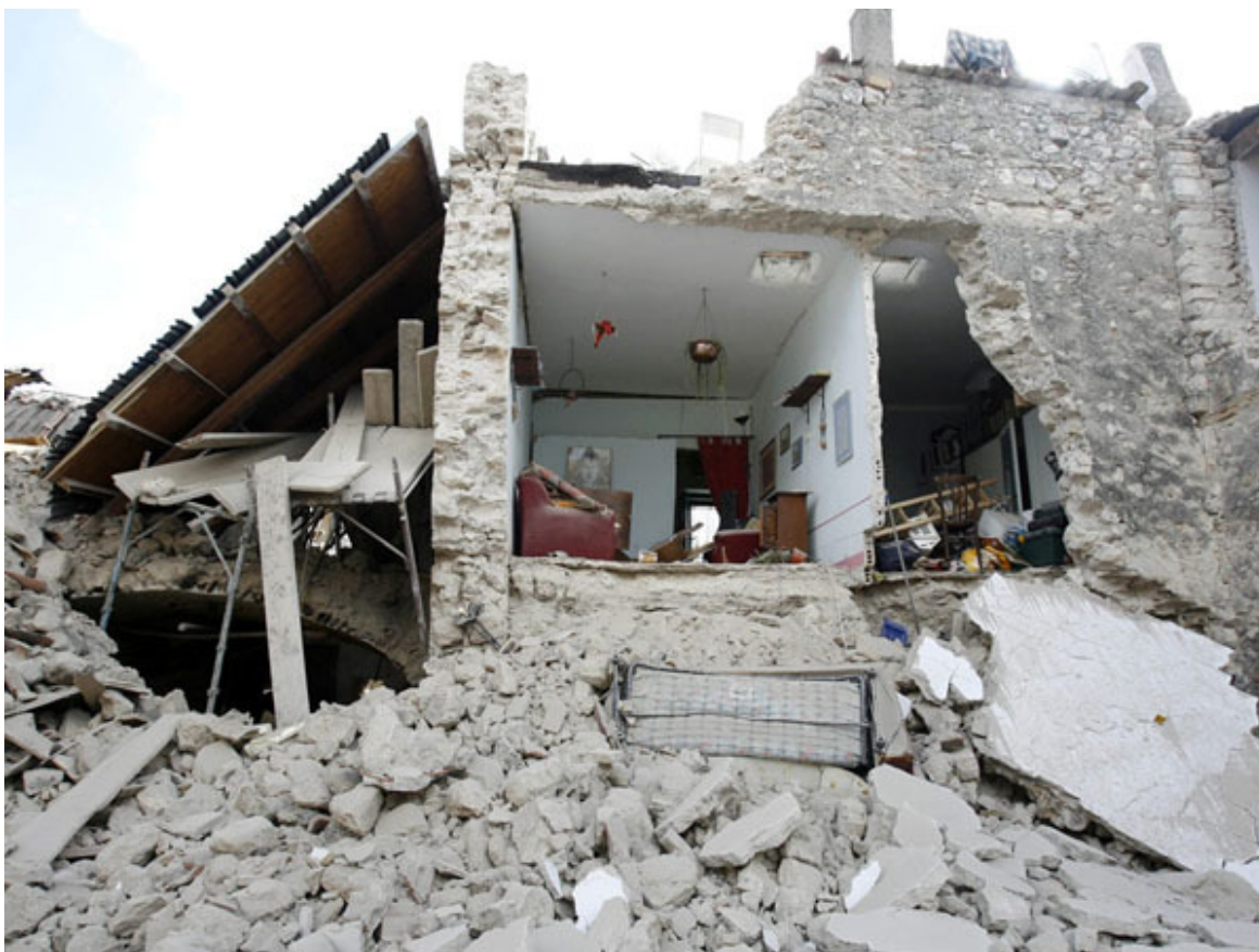
Edificio crollato durante il terremoto del 6 aprile 2009.
