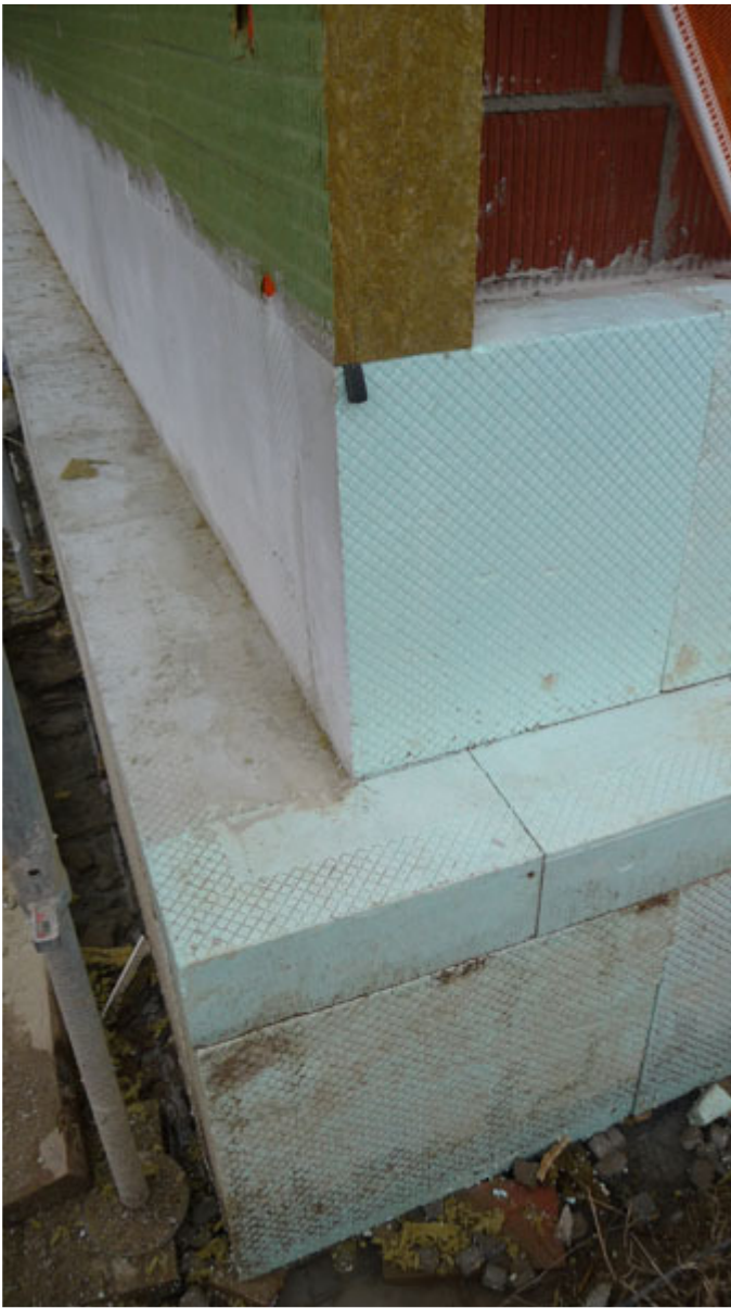
Limena: coibentazione dello zoccolo di fondazione.
