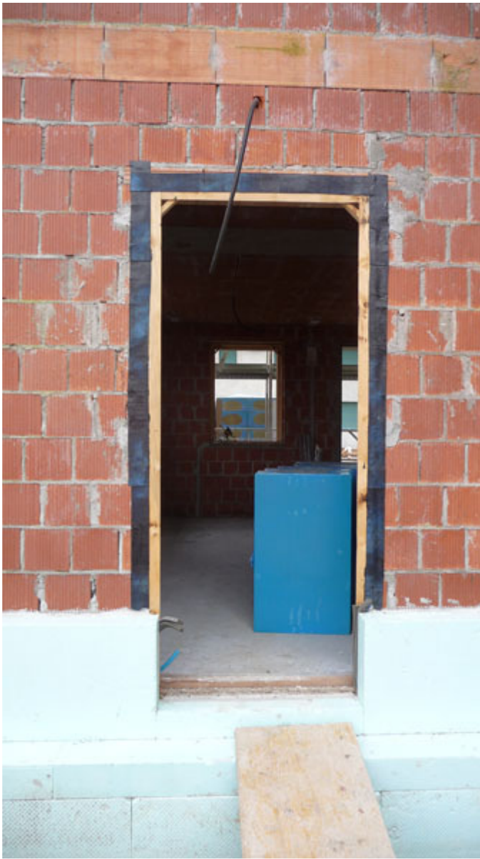
Limena: chiusura ermetica sulle false-casse dei fori porta/finestra.
