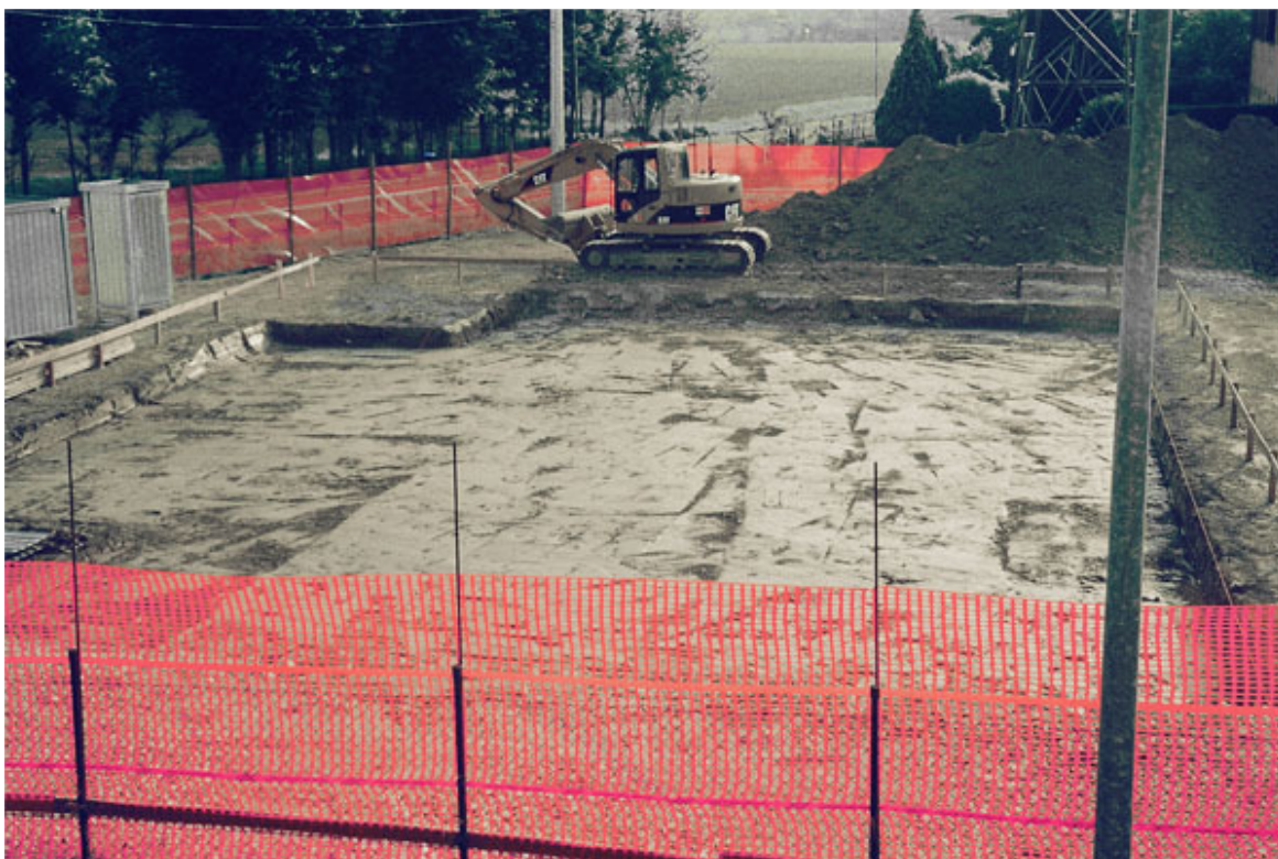
Limena: scavo di fondazione.
