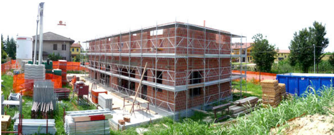
Limena: edificio in costruzione.
