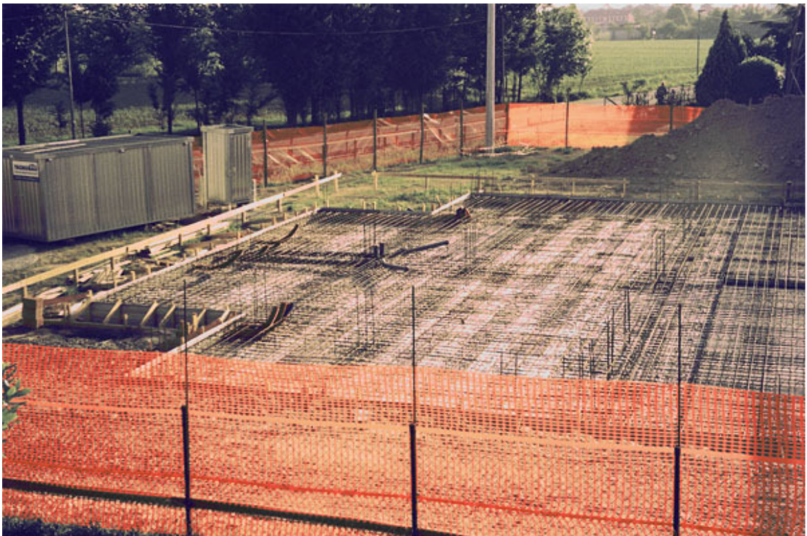
Limena: armatura delle fondazioni.
