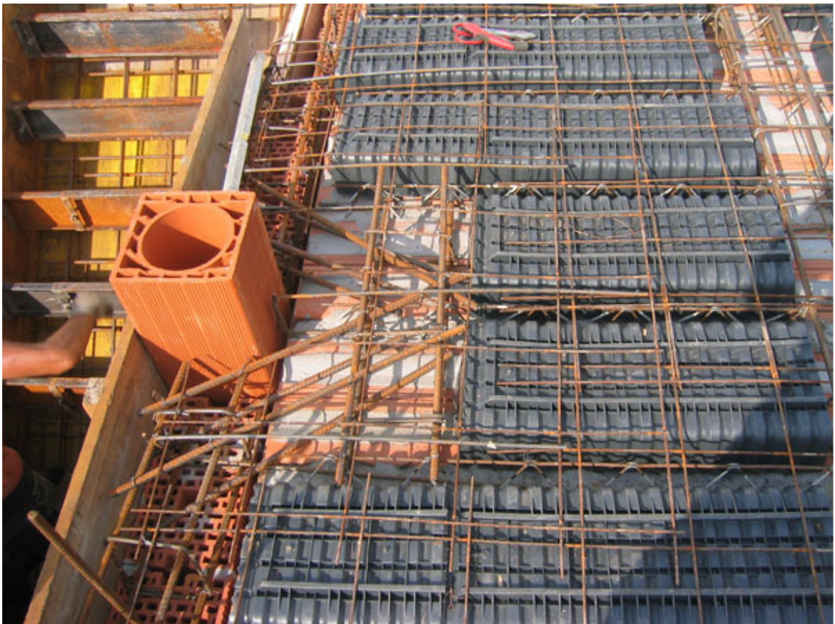
Limena: solaio UNISOL con GEOSOL.
