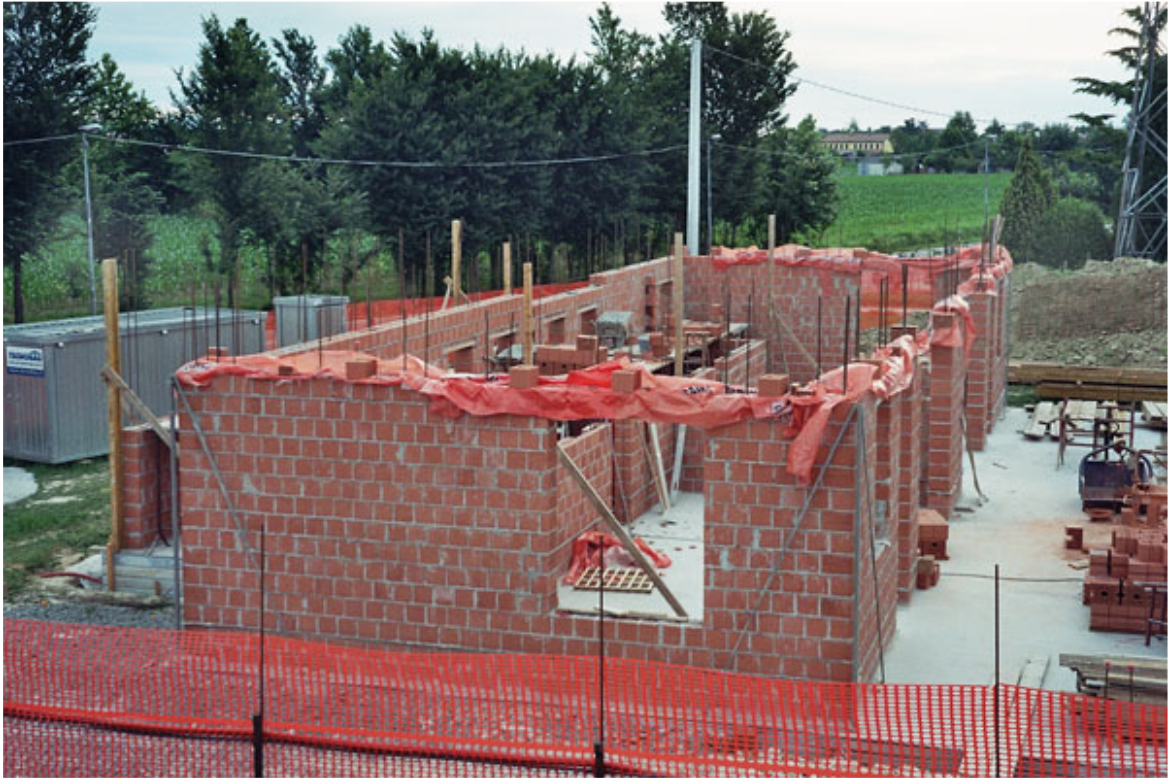
Limena: struttura in muratura armata.
