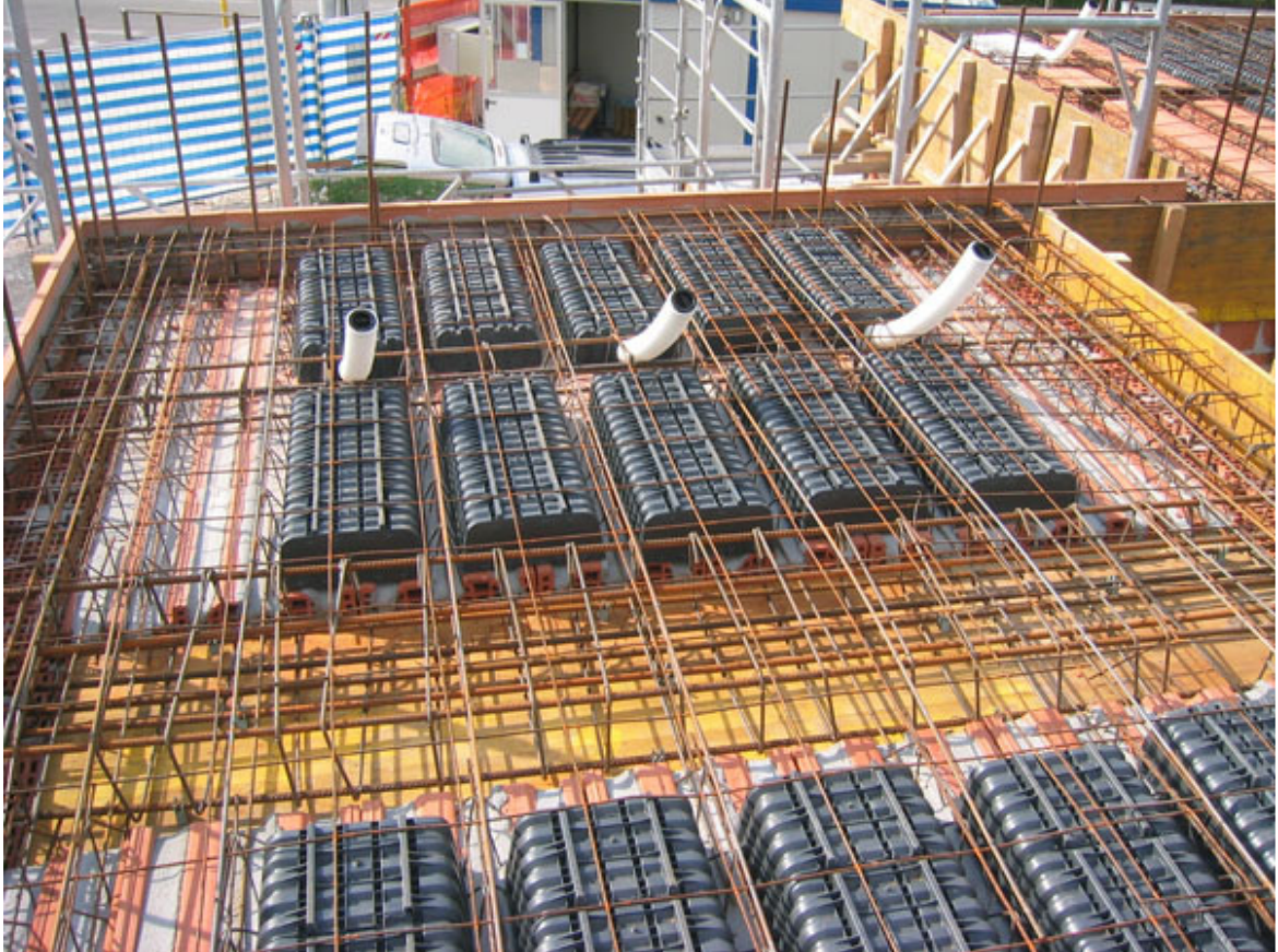
Limena: solaio UNISOL con GEOSOL.
