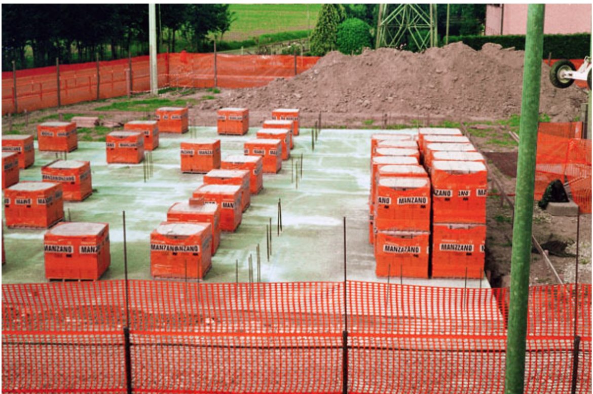
Limena: inizio dell'esecuzione della muratura armata.
