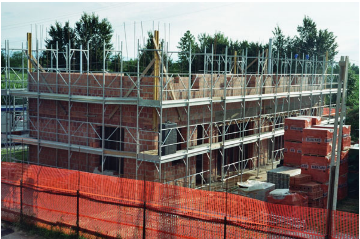
Limena: edificio in costruzione.
