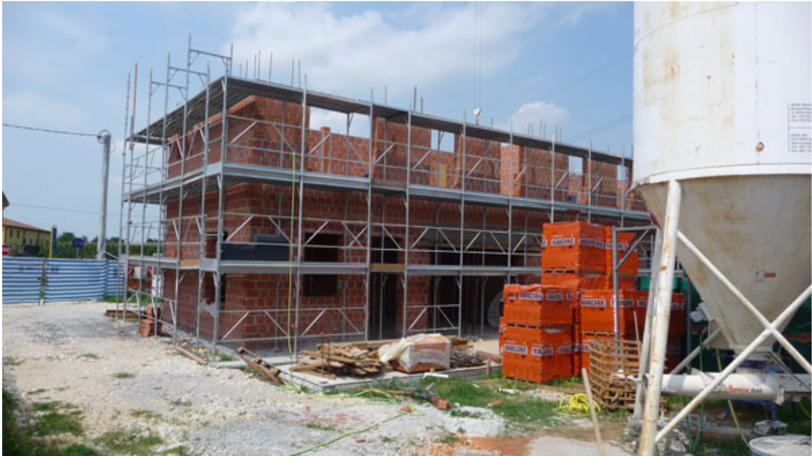
Limena: edificio in costruzione.
