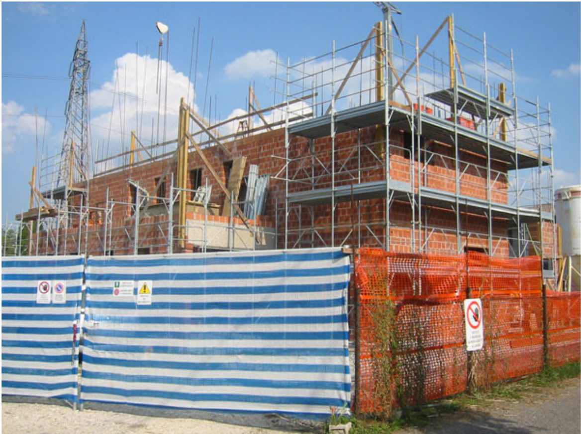
Limena: edificio in costruzione.
