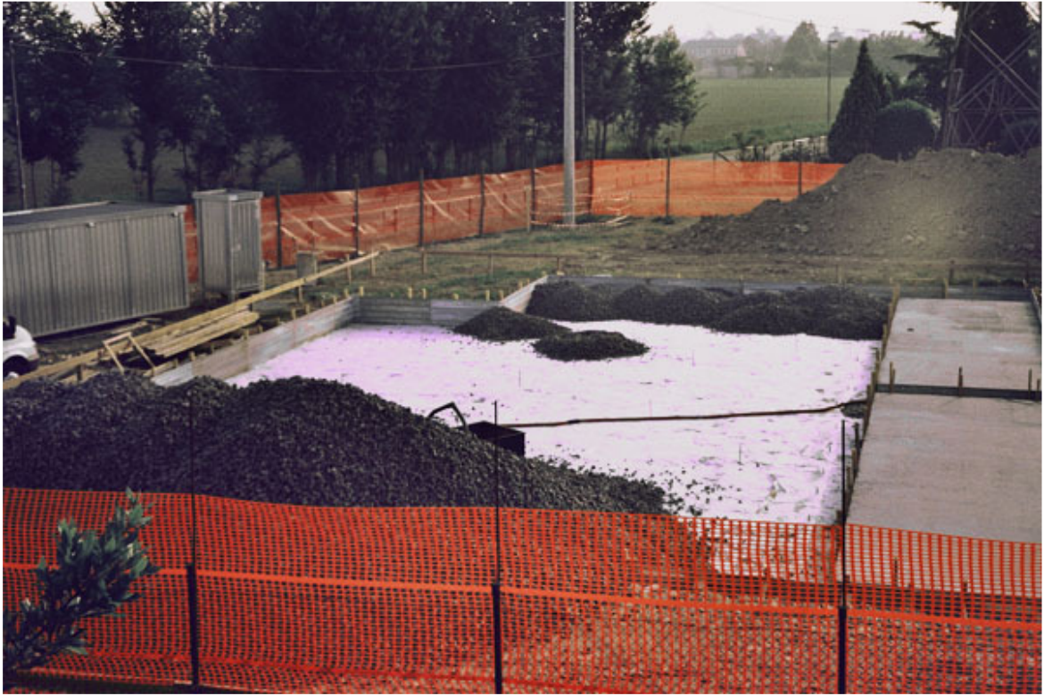
Limena: scavo di fondazione.
