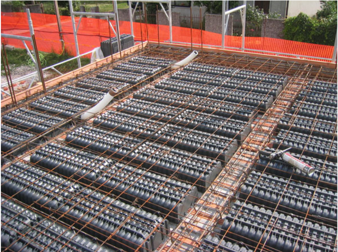
Limena: solaio UNISOL con GEOSOL.
