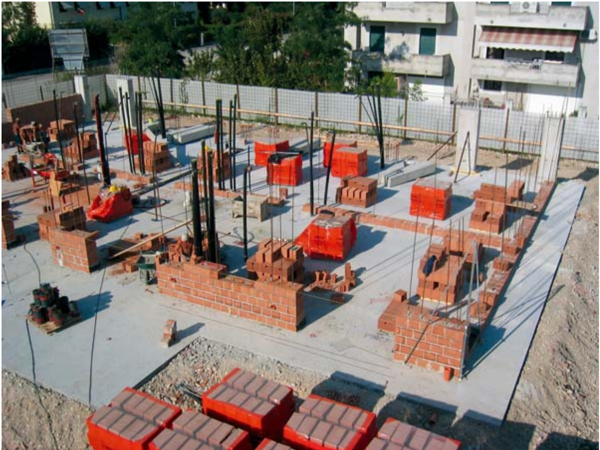
Lotto 1: Fasi di crescita del fabbricato pilota.
