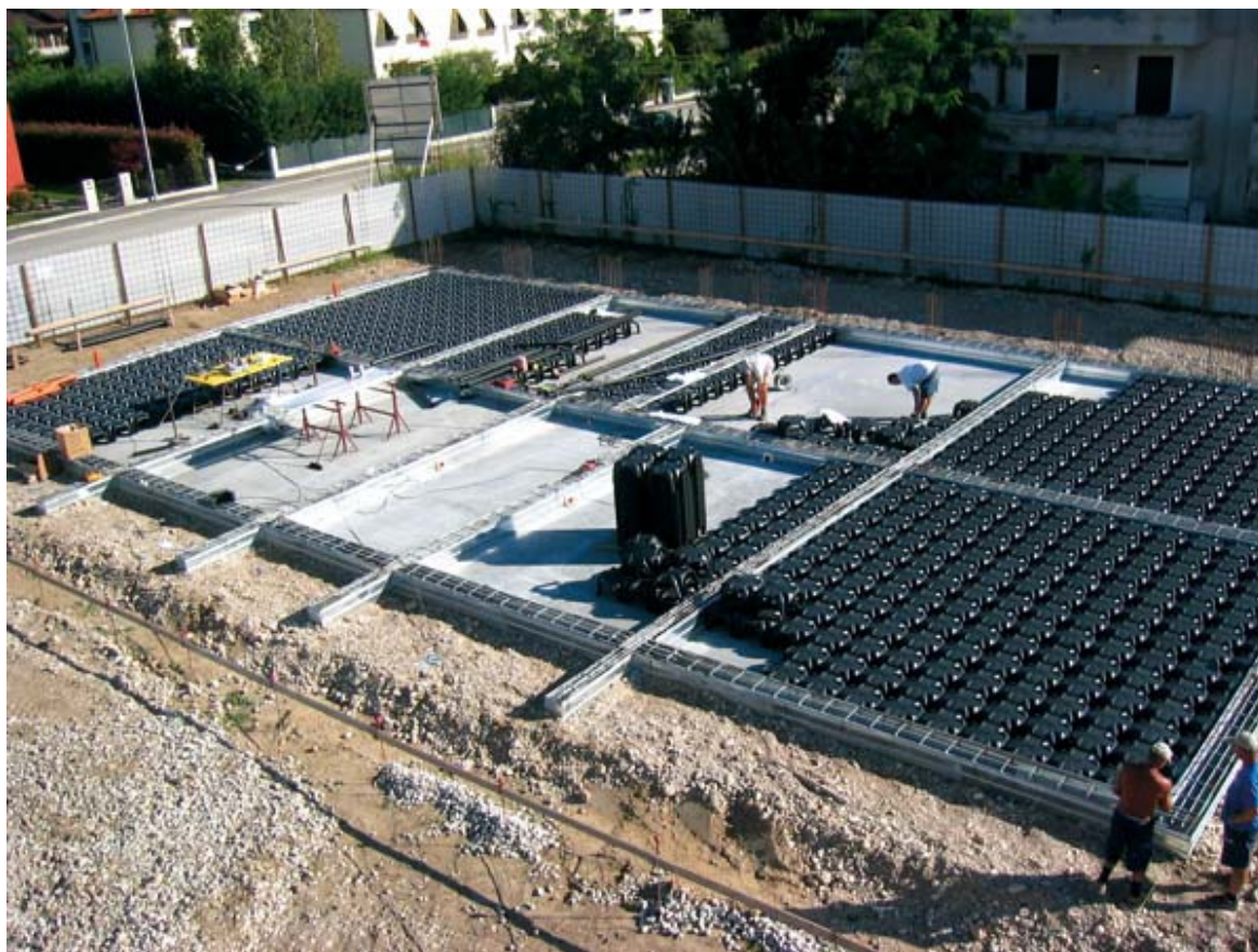
Lotto 1: Fasi di crescita del fabbricato pilota.
