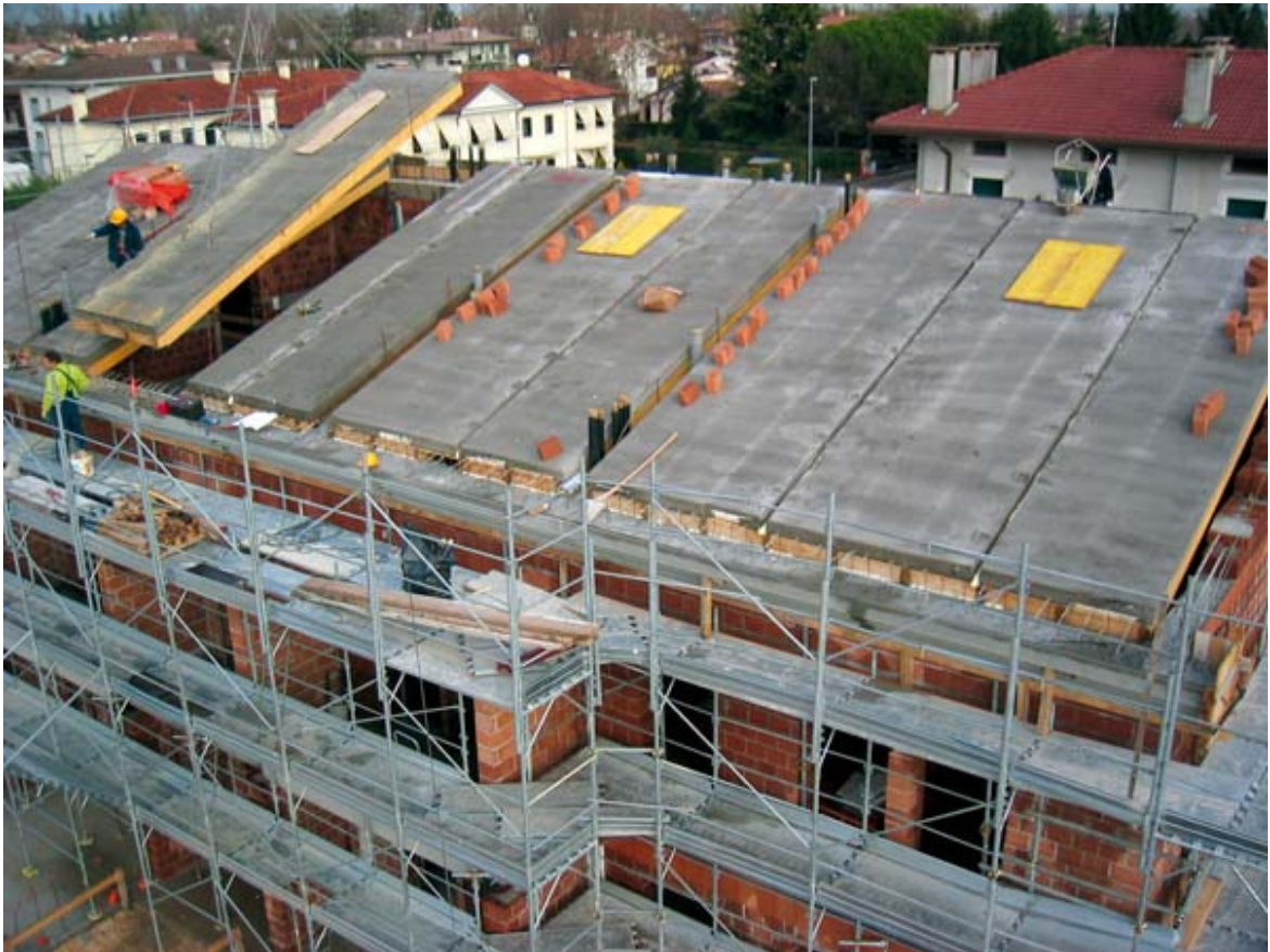
Lotto 1: Fasi di crescita del fabbricato pilota.
