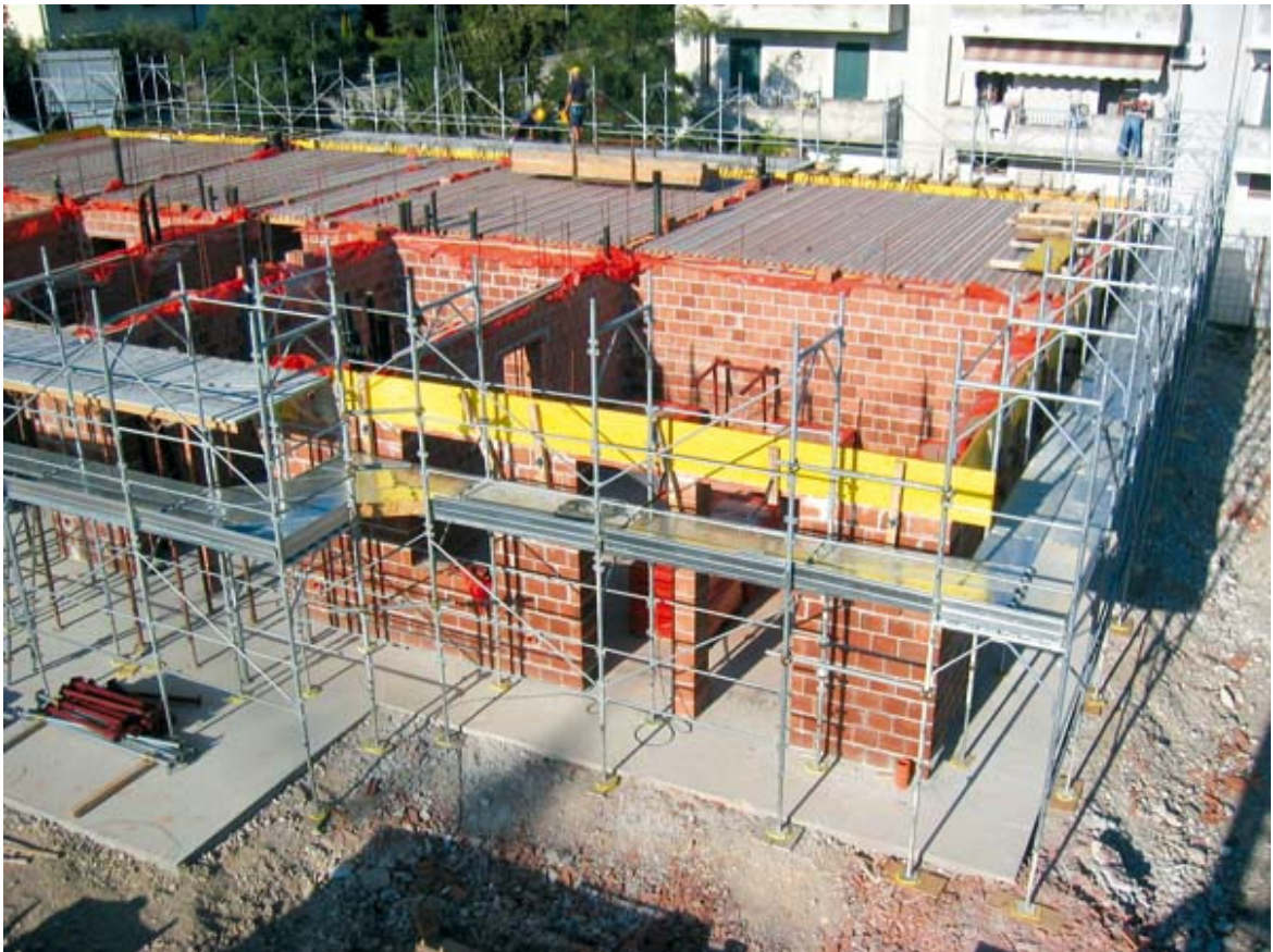
Lotto 1: Fasi di crescita del fabbricato pilota.
