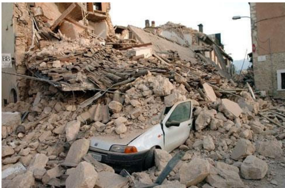
Conseguenze del sisma in Abruzzo.
